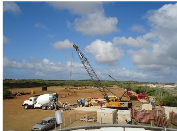
RWZI in aanbouw
